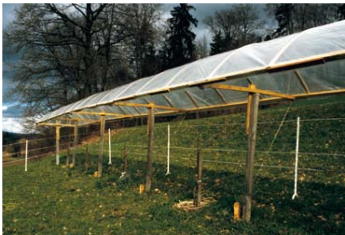
Bois au lieu de métal galvanisé : protection contre les intempéries à « aire ouverte » (prototype)
